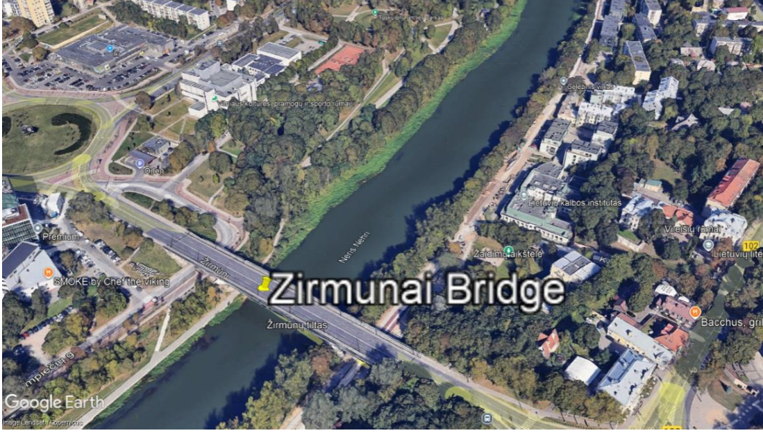
Şekil 3.6: Zirmunai Köprüsü konumu.
