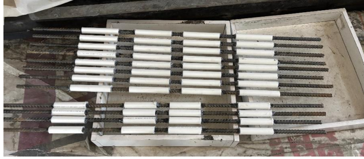
Şekil 6.3: \phi 14 Çelik donatılar ve özel kılıfların yerleştirilmesi
