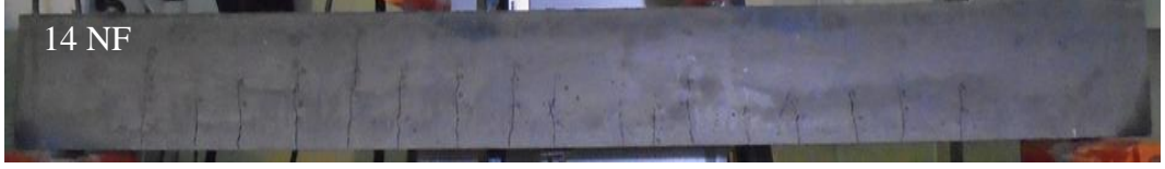
Şekil 3.8: 2φ14 donatılı lifsiz kirişlerin L/250 yerdeğiştirmesi için çatlak dağılımları
