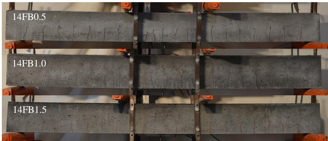
Şekil 3.21: 2 \phi 14 donatılı bazalt lifli kirişlerin L/250 yerdeğiřtirmesi için çatlak dağılımları
