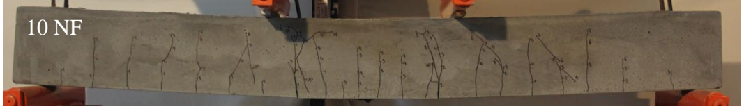
Şekil 3.7: 2φ10 donatılı lifsiz kirişlerin L/70 yerdeğiştirmesi için çatlak dağılımları
