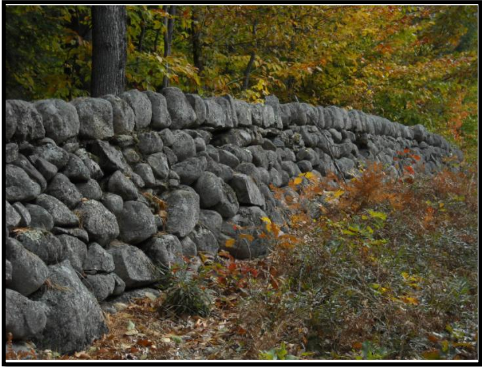
Şekil 17. Kuru Taş Çit/Duvar Örneği
