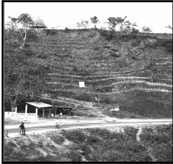
Şekil 16. Teras Yükselticilere Destek İçin Bambu Dikimi
