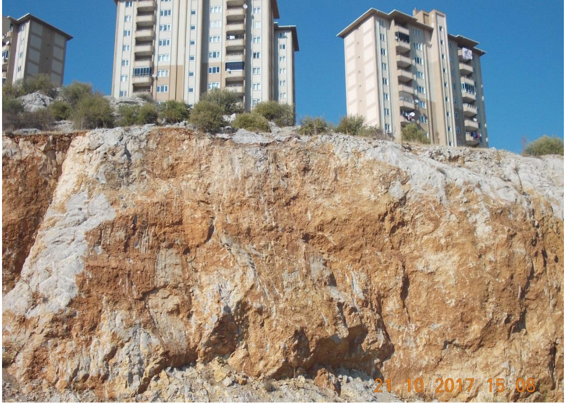
Foto 3: Edremit Merkez TOKİ Konutları Yakınındaki Yol Yarماسında Alt Kretase'ye Ait Kireçtaşlarının Görünümü
