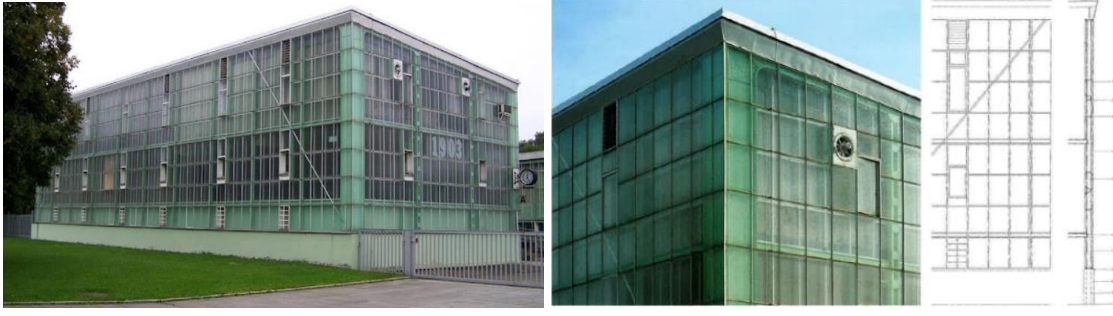
Şekil 2.12: Steiff Fabrikası'nın bugünkü hali ve cephe kısmi kesiti (Solla, 2011).
