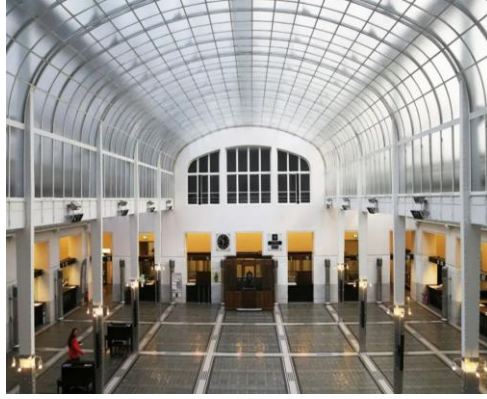
Şekil 2.13: Post Office Savings Bank binası çift kabuk çatı ışıklığı (Mindel, 2024).
