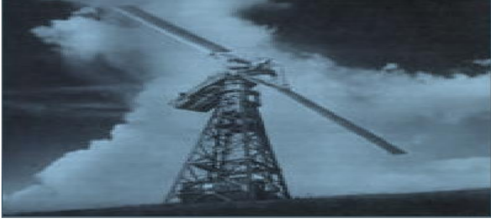
Şekil 2.3: 1.250 MW kapasiteli Smith-Putnam rüzgar türbini [5].
