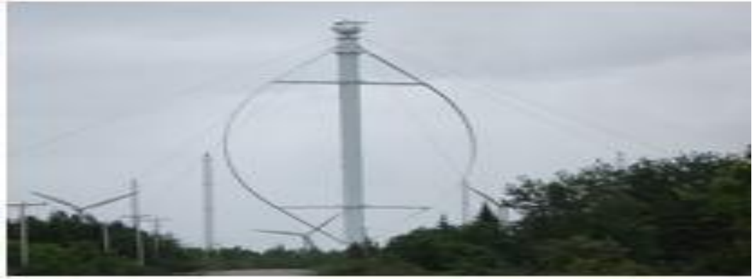
Şekil 3.1: Dikey eksenli bir rüzgar türbini [7].
