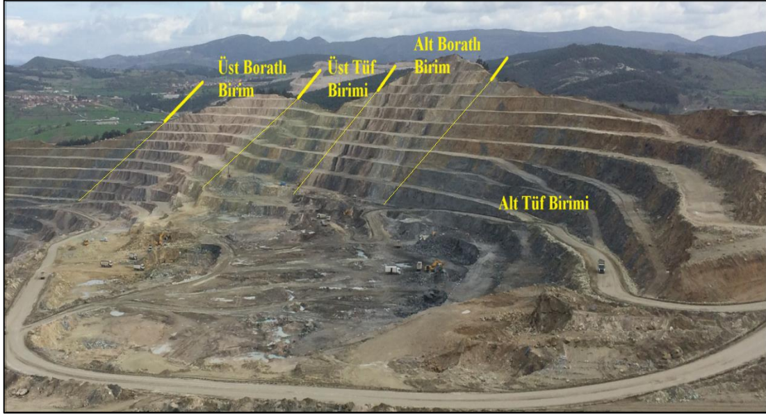
Şekil 3.5: Küçüktepe ve Uzuntepe bölgesinin Kocadağ Tepe'den görüntüsü (Simav Açık Ocağı).
