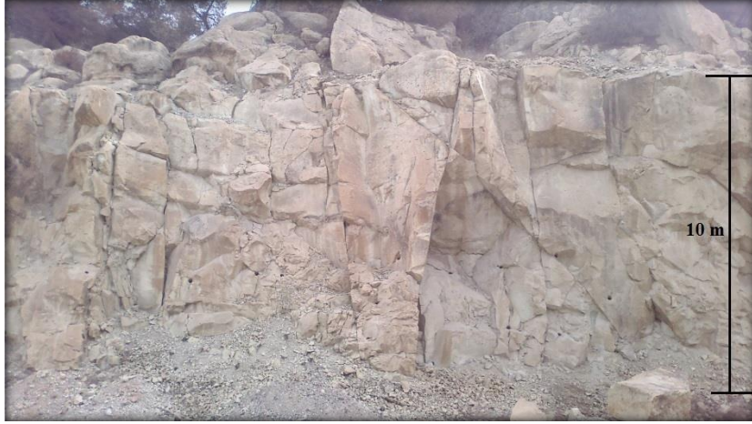
Şekil 3.27: Zeolitik tuf içerisindeki yoğun makaslama çatlakları.
