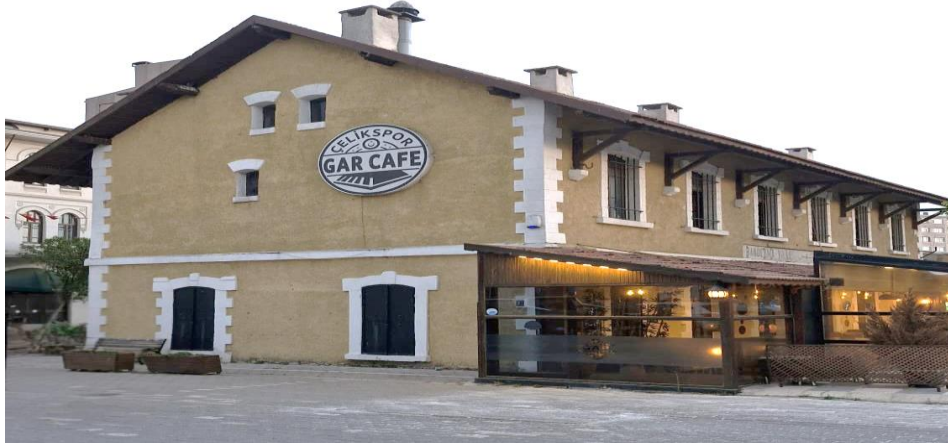
Şekil 9. Eski Gar Binası
