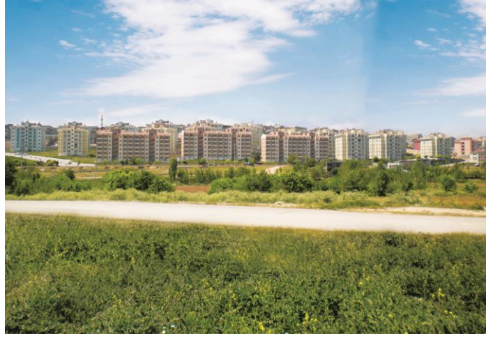
Fotoğraf 1. Havaalanı Yolu Üzerinde Bulunan Perilikaya-Serinevler TOKİ Konutları (12.05.2016).
