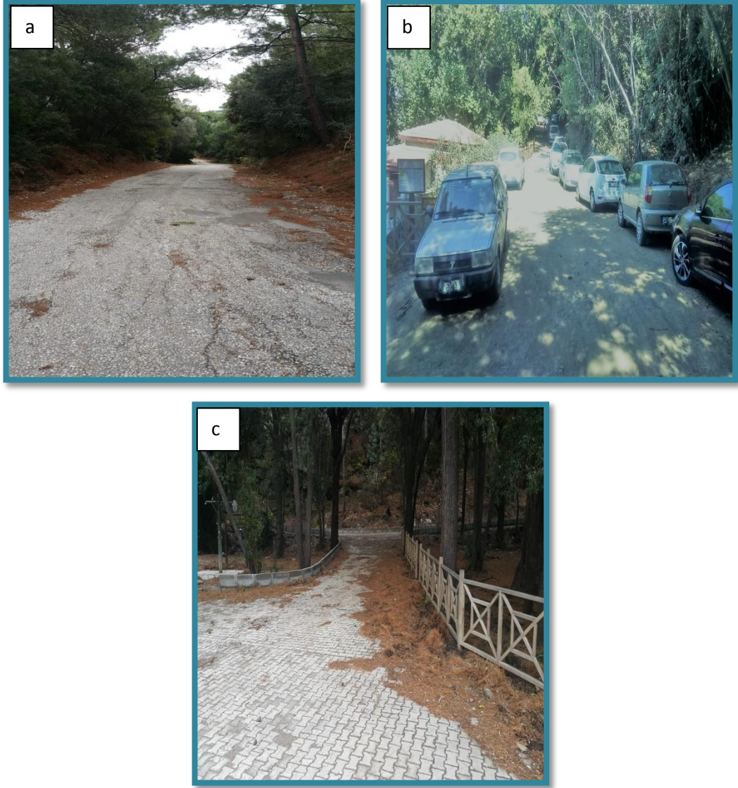
Şekil 5.10: Karasu Koyu yol kaplama türleri, a) Karasu Koyuna giriş yolu asfalt kaplama, b) Karasu Koyu iç ulaşım yolu toprak yol, c) Karasu Koyu iç ulaşım sahil yolu kilit parke kaplamalı yol.
