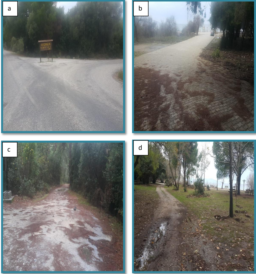
Şekil 5.8: Aydınlık Koyu yol kaplama türleri, a) Aydınlık Koyu giriş- wc bölümü arası asfalt kaplaması, b) Aydınlık Koyu wc-restoran bölümü arası küp taş yol kaplaması, c) Aydınlık Koyu bağlantı yolu toprak yol, d) Aydınlık Koyu koy içi ulaşımında kullanılan toprak yol.
