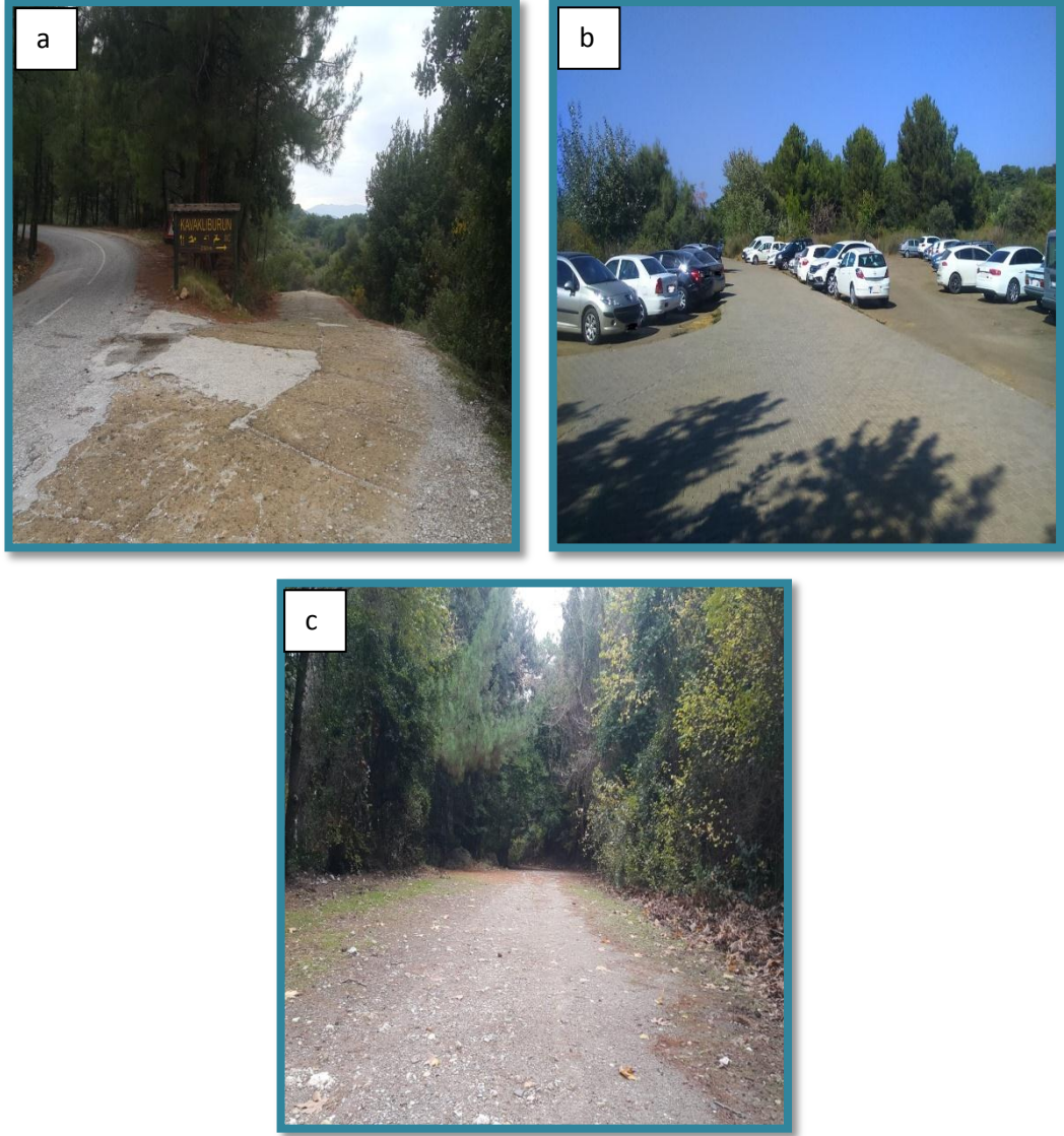
Şekil 5.9: Kavaklıburun Koyu yol kaplama türleri a) Kavaklıburun Koyu giriş noktası asfalt kaplama, b) Kavaklıburun Koyu wc ile sahil bölümü arası küp taş yol kaplaması, c) Kavaklıburun Koyu ara bağlantı yolunda kullanılan toprak yol.
