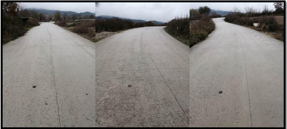
Şekil B.8: Yenice ilçesi Yeniköy-Hacılar yolu 2024 görselleri (Karotlar 1-1, 1-2, 1-3)
