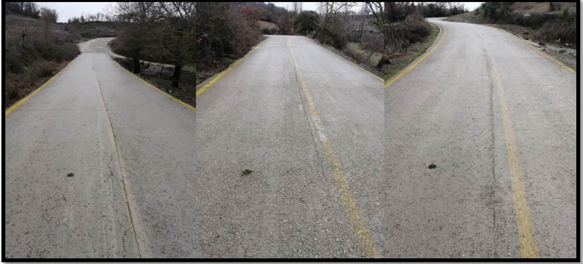
Şekil B.13: Yenice ilçesi Yeniköy-Hacılar yolu 2024 görselleri (Karotlar 6-1, 6-2, 6-3)
