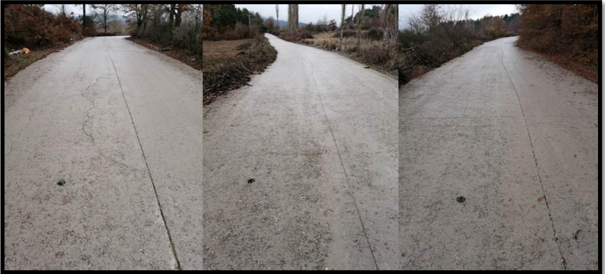
Şekil B.10: Yenice ilçesi Yeniköy-Hacılar yolu 2024 görselleri (Karotlar 3-1, 3-2, 3-3)
