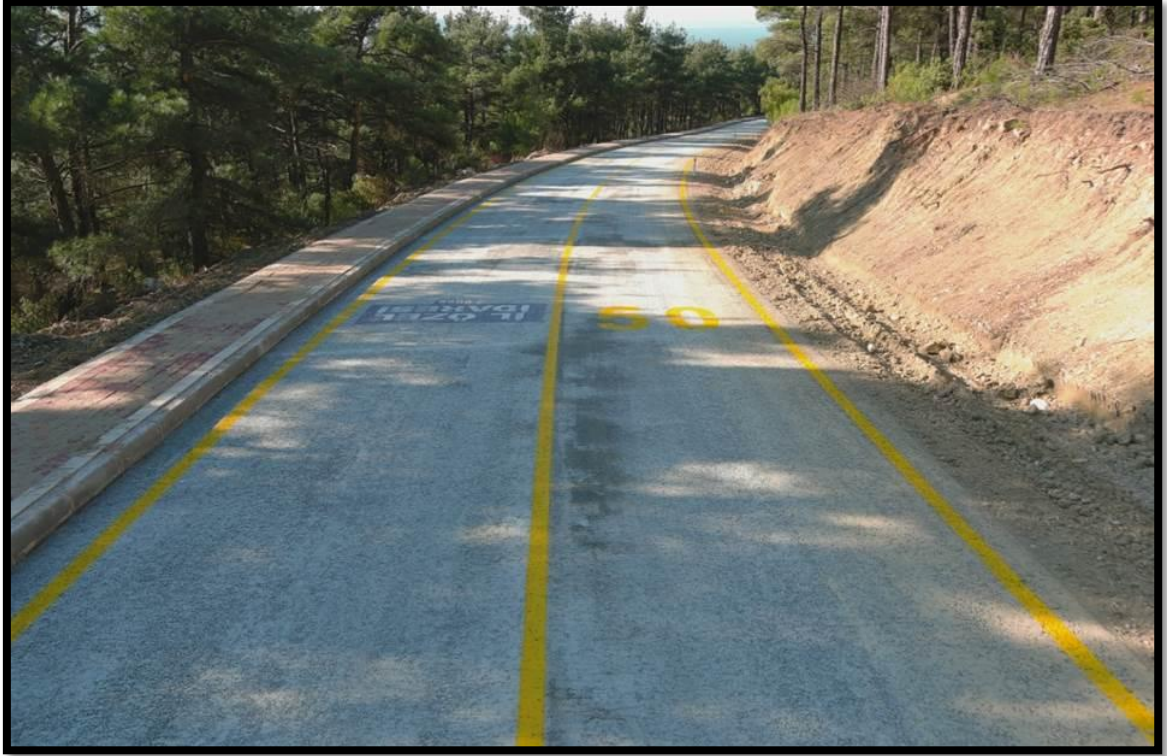
Şekil 4.19: Silindirle sıkıştırılmış beton yol (Çanakkale-2022)
