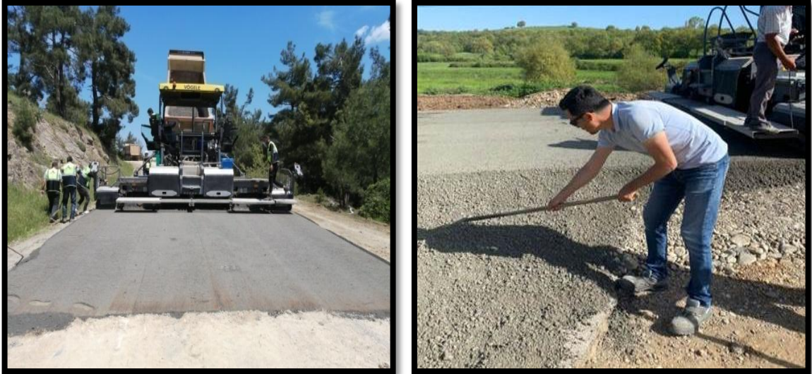
Şekil 4.26: Finişerle beton serim uygulaması (Çanakkale köy yolları)
