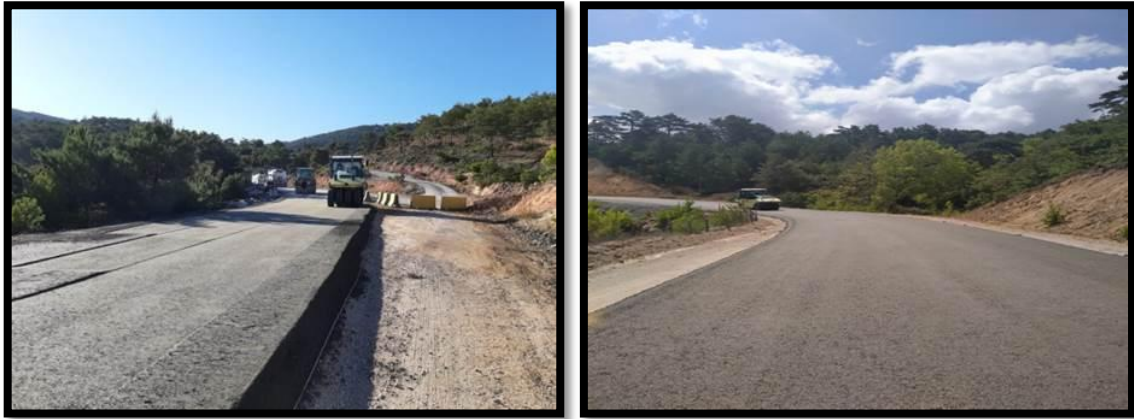
Şekil 4.27: Silindirle sıkıştırma uygulaması (Çanakkale köy yolları)
