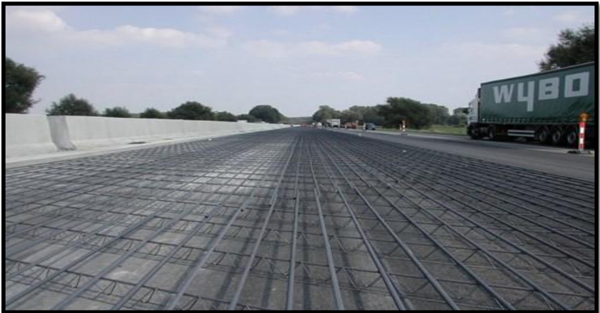
Şekil 4.20: Sürekli donatılı beton yol [29]
