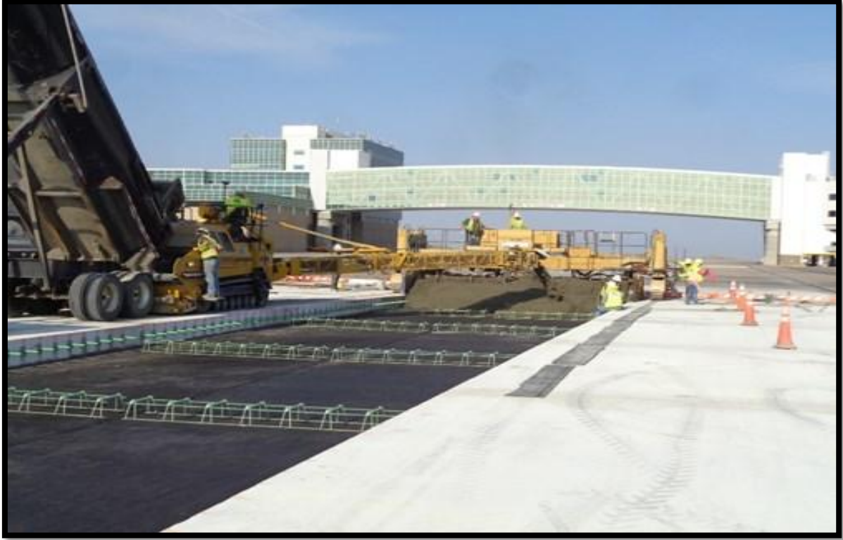
Şekil 4.22: Derzli donatısız beton yol [30]
