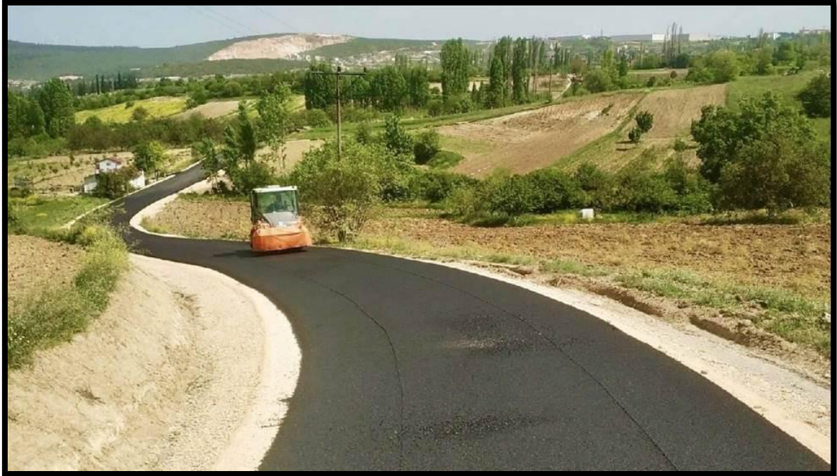
Şekil 4.7: Köy yolunda binder tabakası [21]
