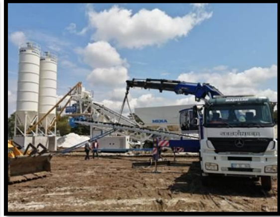
Şekil 4.25: Beton santrali
