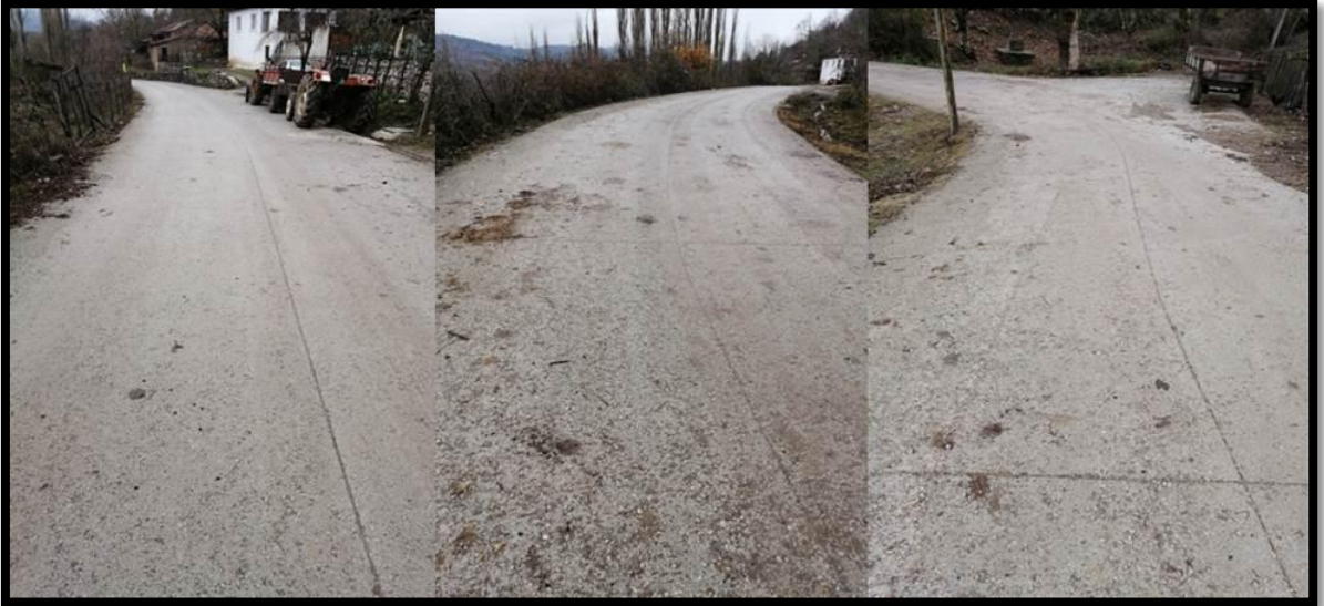
Şekil B.12: Yenice ilçesi Yeniköy-Hacılar yolu 2024 görselleri (Karotlar 5-1, 5-2, 5-3)
