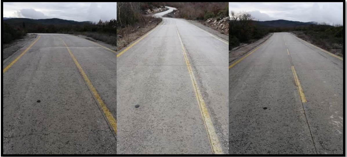
Şekil B.16: Yenice ilçesi Yeniköy-Hacılar yolu 2024 görselleri (Karotlar 9-1, 9-2, 9-3)
