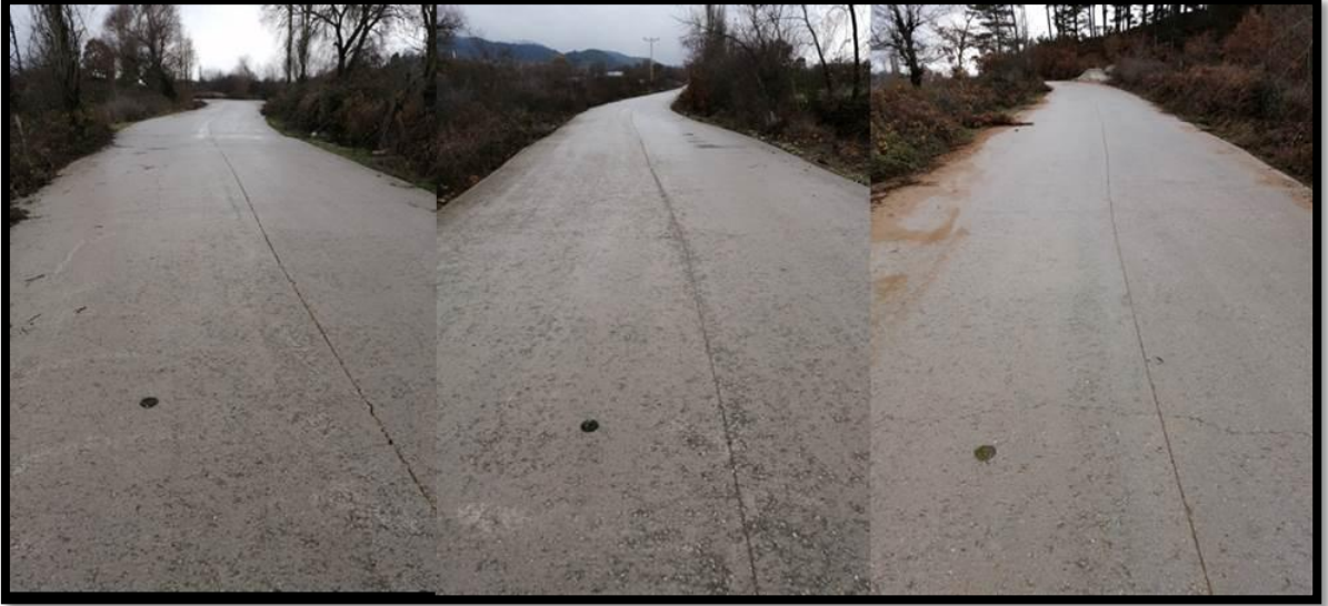
Şekil B.9: Yenice ilçesi Yeniköy-Hacılar yolu 2024 görselleri (Karotlar 2-1, 2-2, 2-3)
