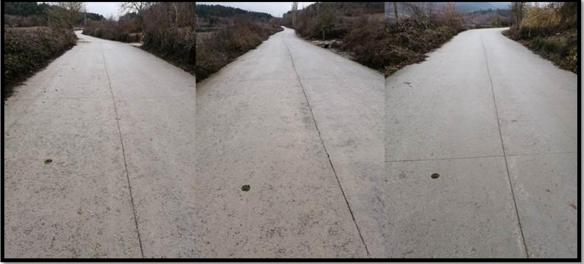
Şekil B.11: Yenice ilçesi Yeniköy-Hacılar yolu 2024 görselleri (Karotlar 4-1, 4-2, 4-3)
