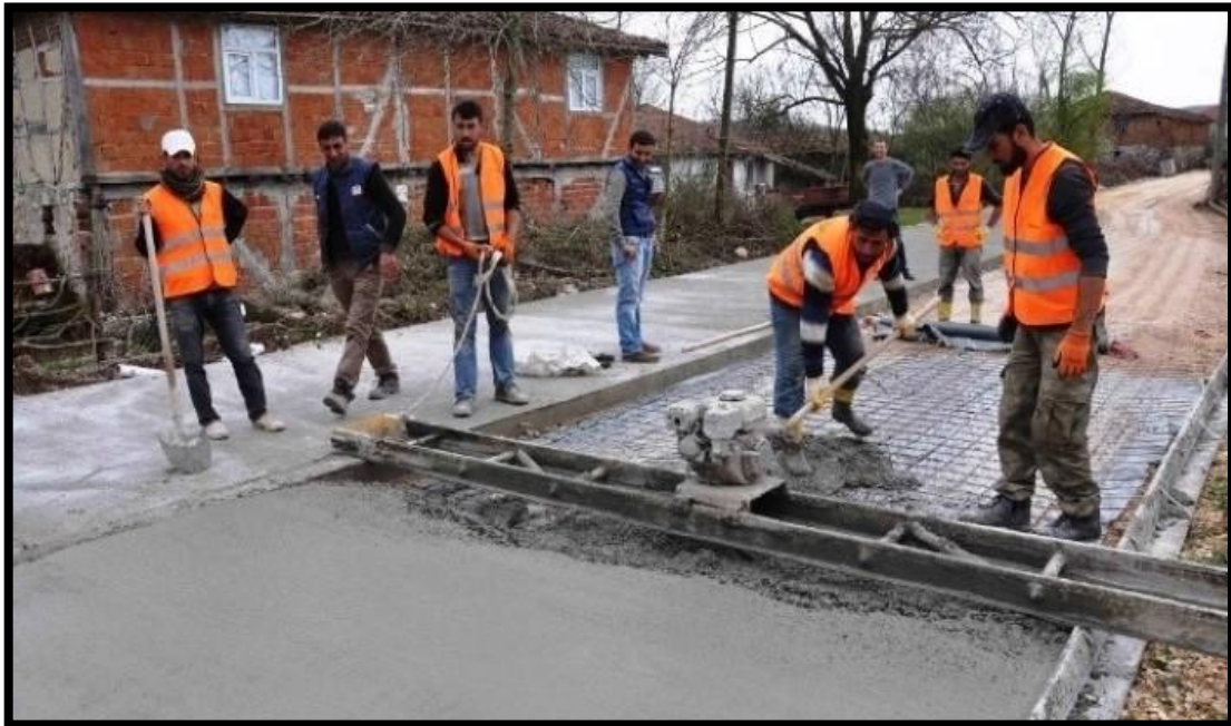
Şekil 4.23: Sürekli donatılı geleneksel yaş beton köy yolu [32]
