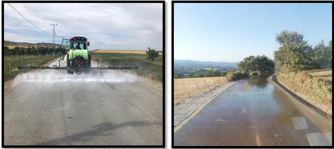
Şekil 4.28: Kimyasal kütleme ve suyla kütleme uygulamaları (Türkmenli-Sarıdüz yolu)
