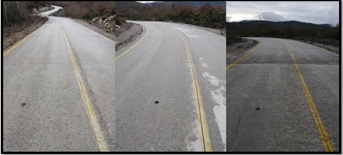
Şekil B.15: Yenice ilçesi Yeniköy-Hacılar yolu 2024 görselleri (Karotlar 8-1, 8-2, 8-3)
