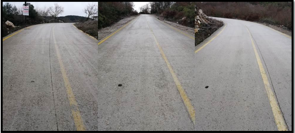
Şekil B.14: Yenice ilçesi Yeniköy-Hacılar yolu 2024 görselleri (Karotlar 7-1, 7-2, 7-3)
