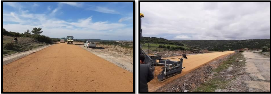
Şekil 4.24: Plent-miks temel tabakası serme-sıkıştırma (Ayvacık-Tuzla grup yolu)
