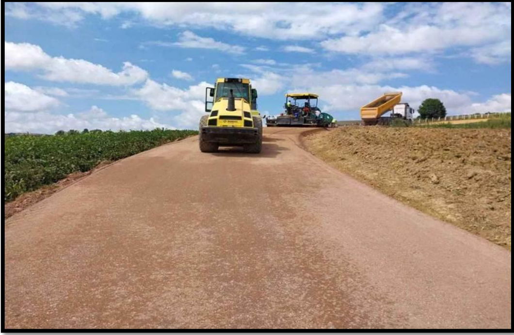
Şekil 4.6: Köy yolunda plent-miks temel tabakası [20]
