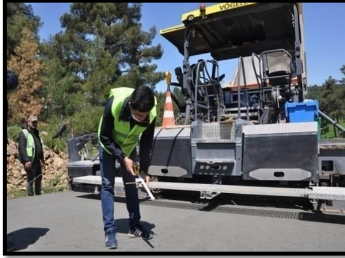
Őekil 4.32: Kalınlık kontrol (Umurbey-Hacıgelen yolu) (2020)
