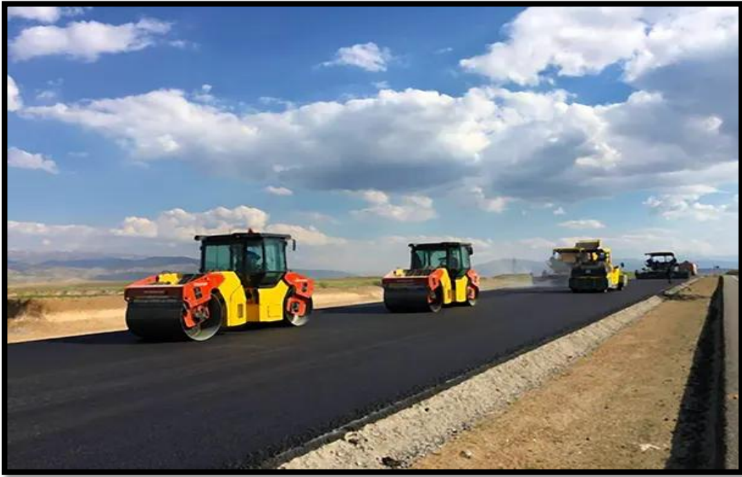
Şekil 4.4: Bitümlü sıcak karışım yol [16]
