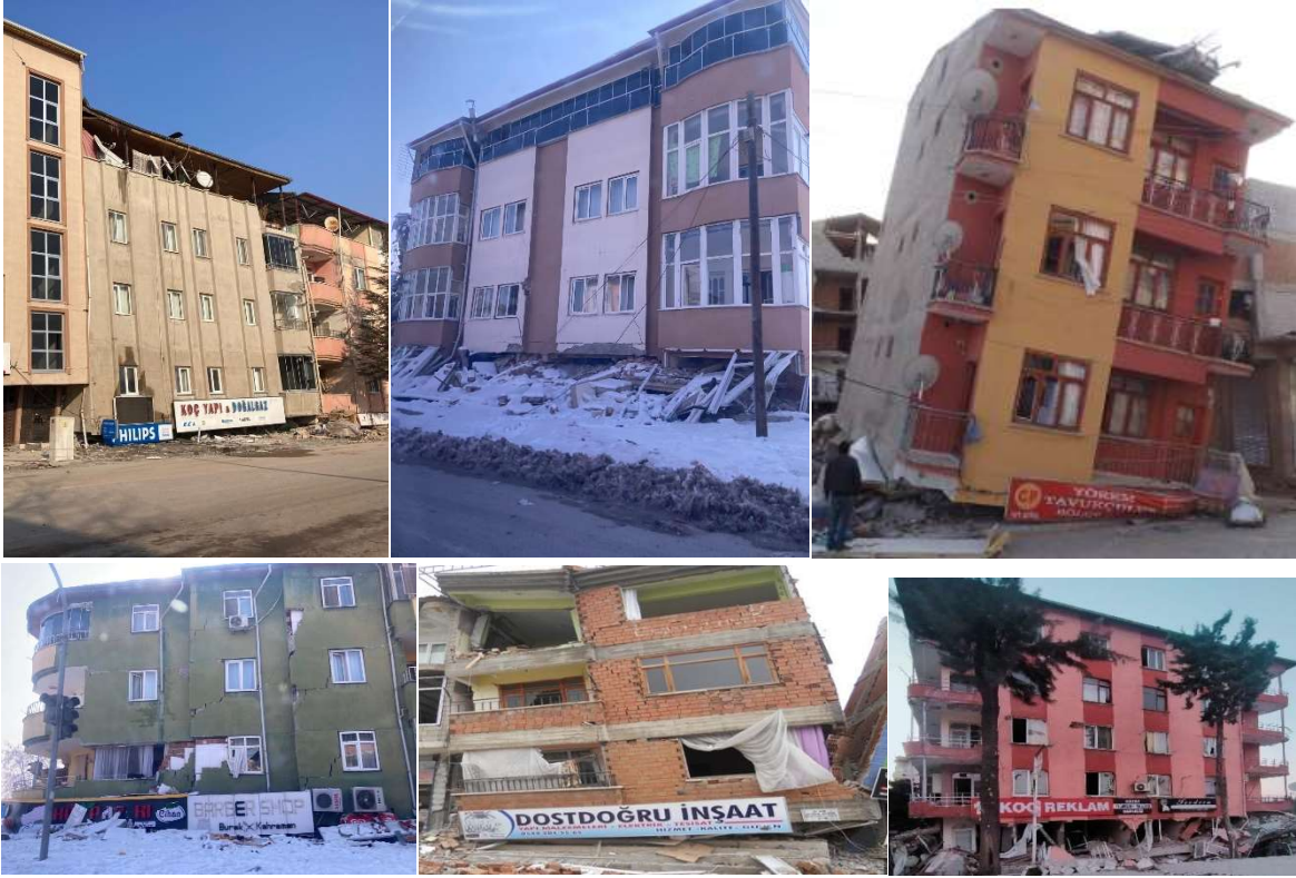
Şekil 1.4: Türkiyede yaşanan depremlerde gözlenen yumuşak kat göçmeleri
