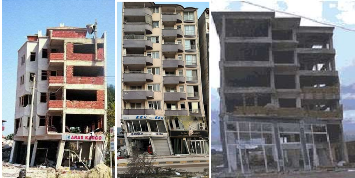
Şekil 1.5: Yumuşak kat nedeniyle ağır hasarlı bina örnekleri
