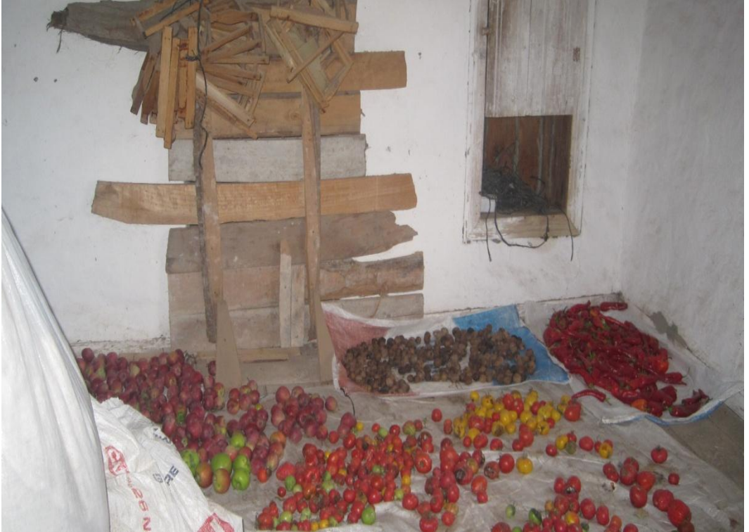
Şekil 40. Tahta Çakılarak Kapatılmış Bacalık-Şabanlar Köyü
