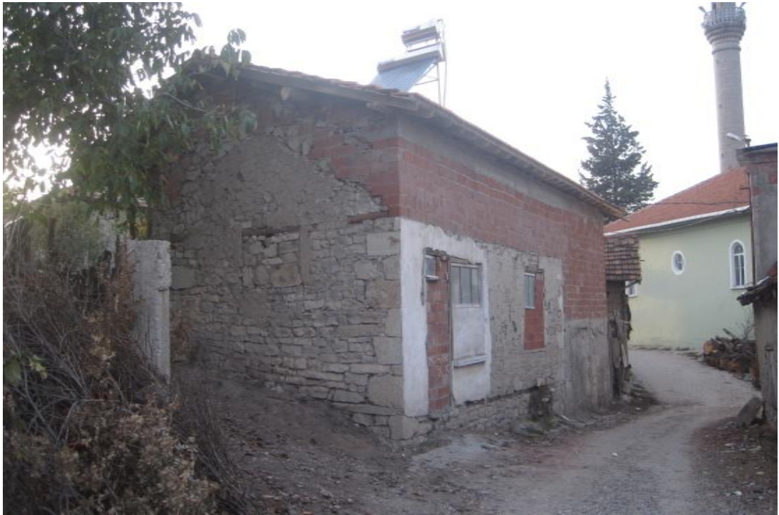
Şekil 24. Geleneksel Malzemeli Eve Modern Malzeme İle Ekleme -Şabanlar Köyü
