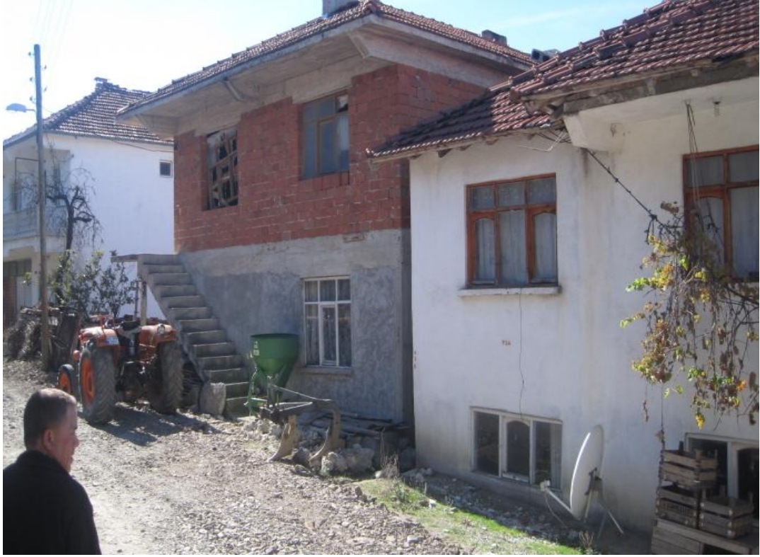
Şekil 12. Modern Mesken, Betonarme Merdiven-Umurlar Köyü
