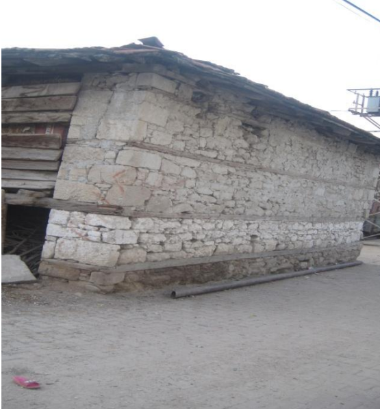
Şekil 21. Taş Duvar ve Hatıllar Şabanlar Köyü
