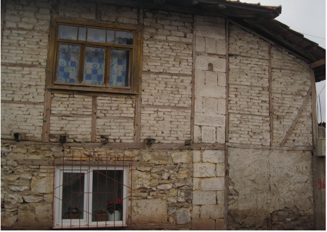
Şekil 6. Karkas Yapıya Örnek-Akbaşlar Köyü
