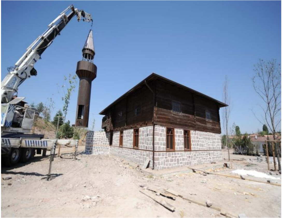
Şekil 2. Karabük'ten Altındağ'a Getirilen Caminin Montajı
