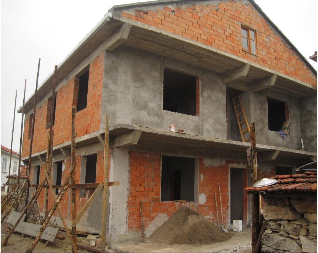
Şekil 9. Modern Ev İnşası-Umurlar Köyü
