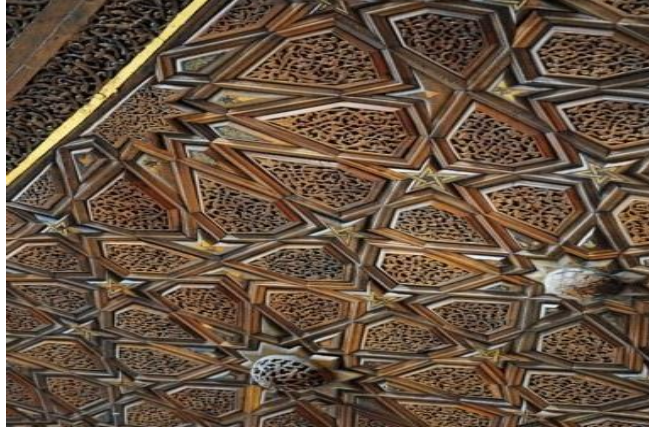
Şekil 8. Bursa Ulu Cami Minberindeki Kündekari Tekniği Örneği
