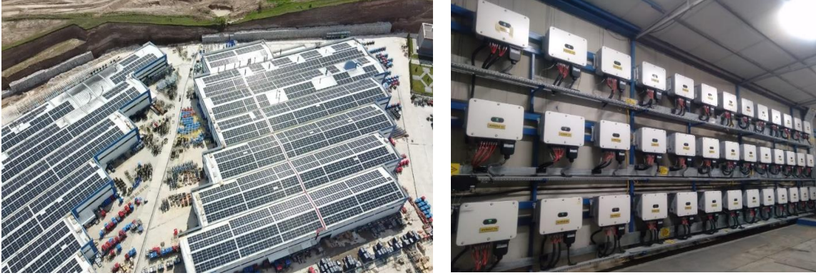
Şekil 3.5: Panel - invertör yerleşim uygulama örnekleri
