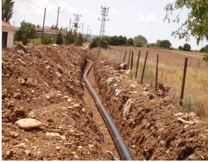
Şekil 2.3 Borulu şebeke inşaat hali
