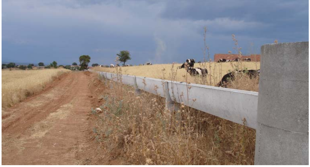
Şekil 2.2 Kanaletli sulama şebekesi
