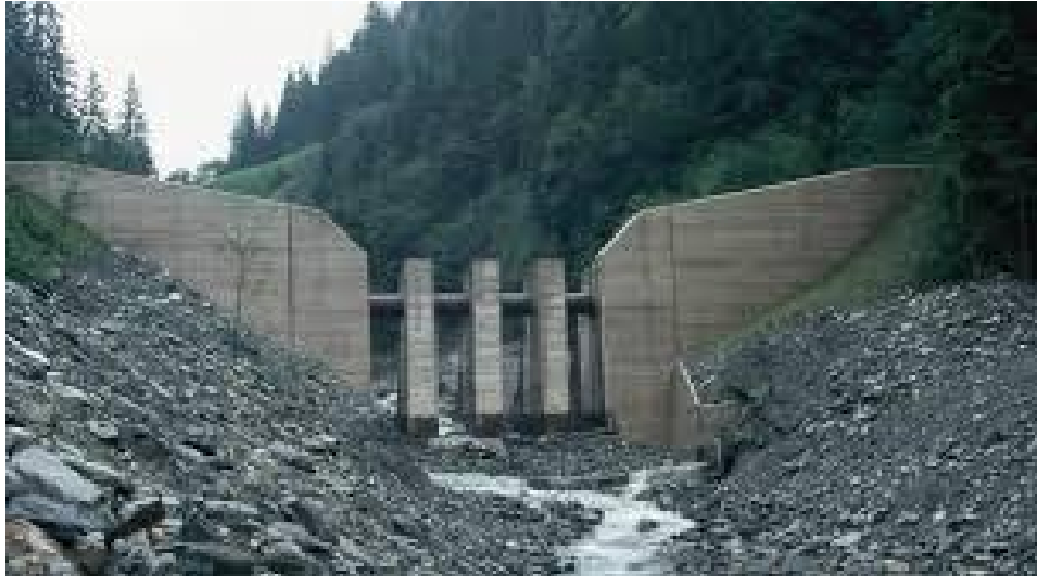
Şekil 1.7: Geçirgen tersip bendi.
