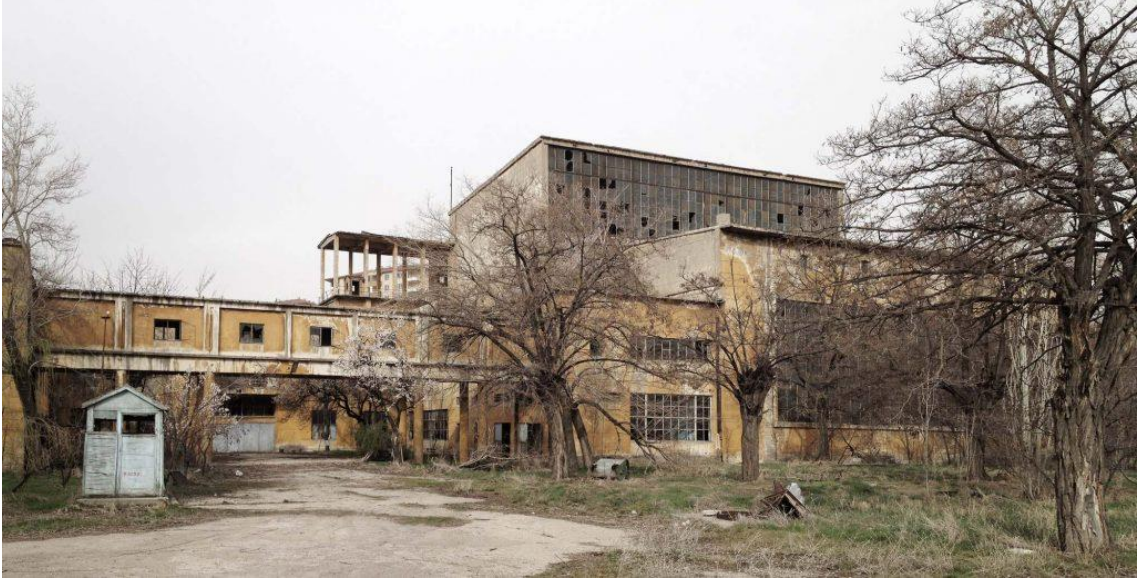
Şekil 3.17: Yapıların Müdahale Öncesi Durumu (Arolat, 2017).
