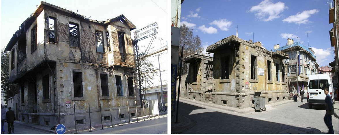
Şekil 3.20: Yapının yangından önceki ve sonraki hali (Yılmaz, Yakar, Güleç, & Dülgerler, 2007).
