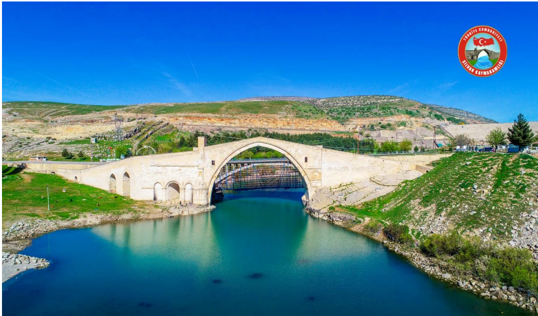
Fotoğraf 11: Malabadi Köprüsü
