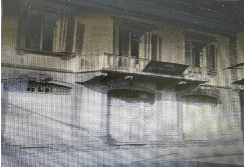
Resim 2: Ayvalık Öksüz Yurdu ve Sanat Mektebi Binası 27
