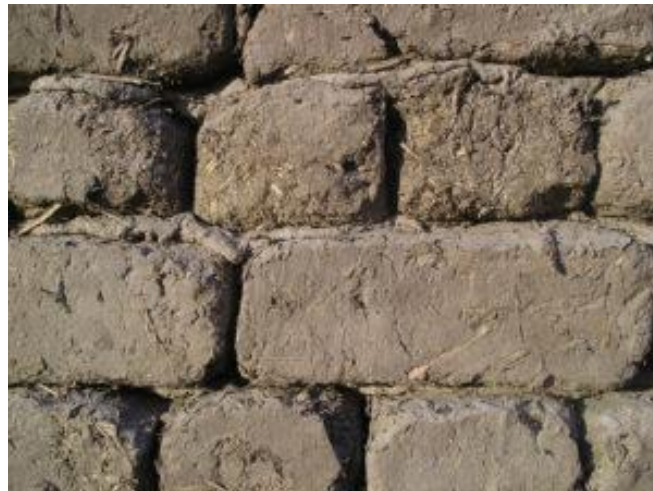
Şekil 2.1: Saman takviyeli kil tuğla örneği.
