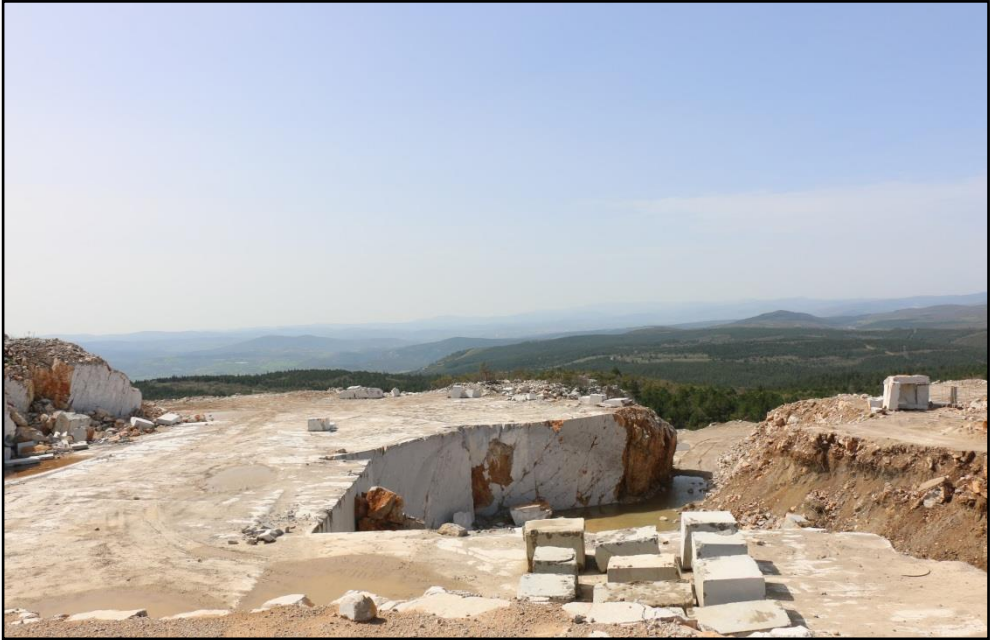
Şekil 45. Akarpınar Tepenin Kuzeydoğusunda Bulunan Mermer Ocağı
