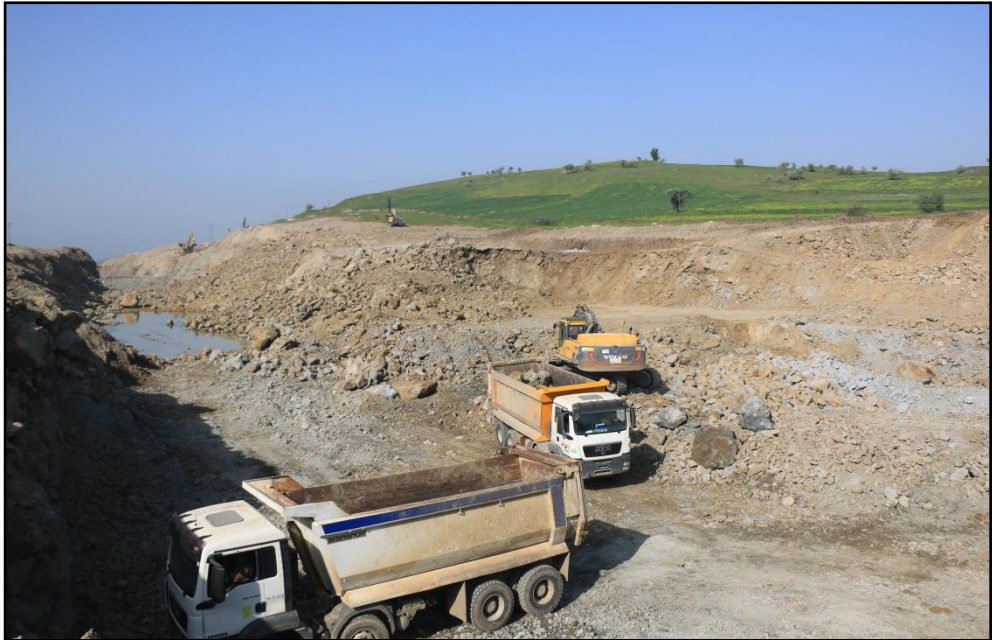
Şekil 43. İstanbul-Bursa-İzmir Otoyol Projesi Şantiyesi
