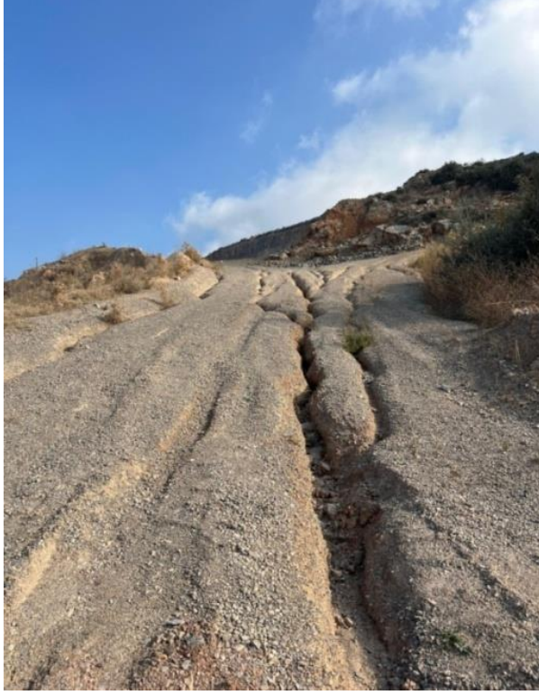
Fotoğraf 8. Çalışma Sahasında Yer Alan Taş Ocaklarının Neden Olduğu Parmak (Rill) Erozyonu Örneği (Kaynak: Orijinal 28.10.2024).
