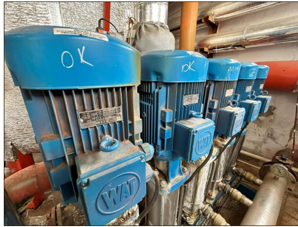
Şekil 3.18: Turistik jeotermal tesisleri destekleyen sirkülasyon pompaları
