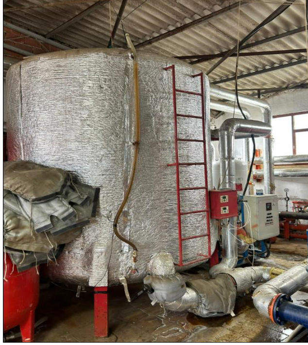
Şekil 3.17: Jeotermal depo
