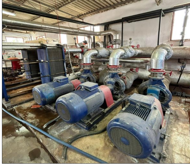
Şekil 3.16: Isı merkezinin içeriden görünümü
