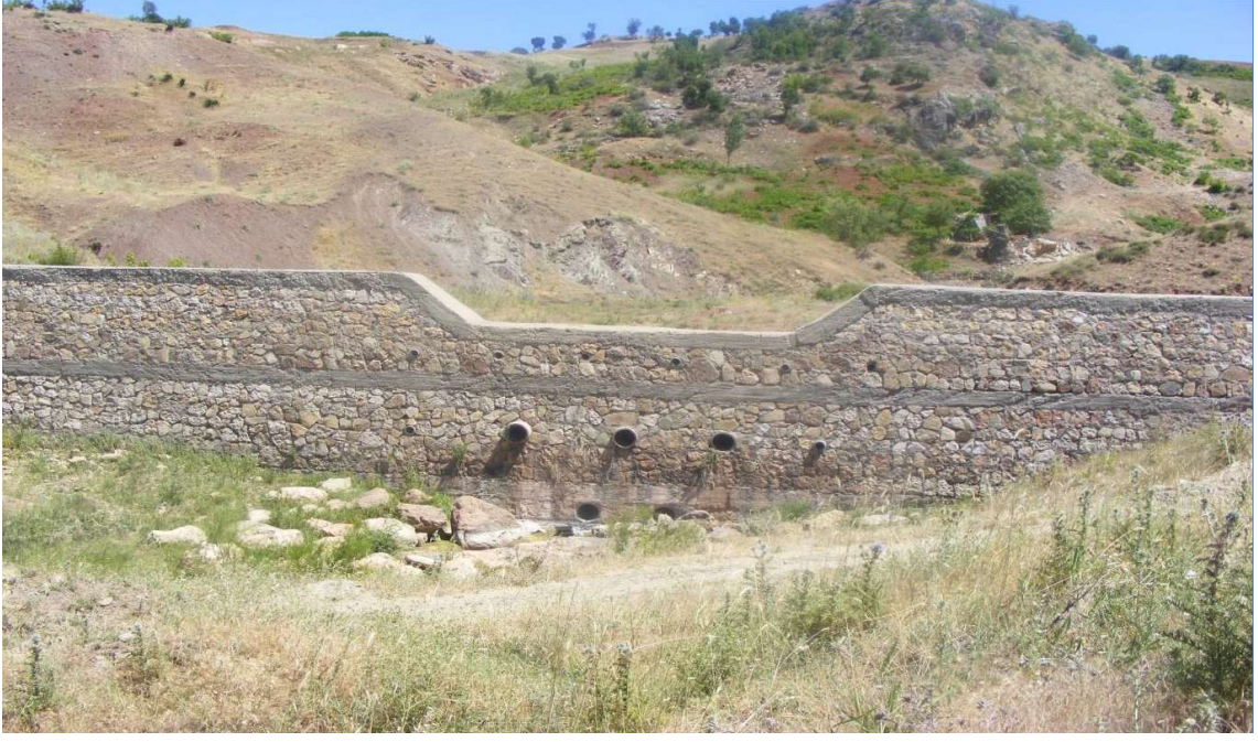
Şekil 1.8: Kargir tersip bendinde yatay hatlı uygulaması (DSİ, 2019).
