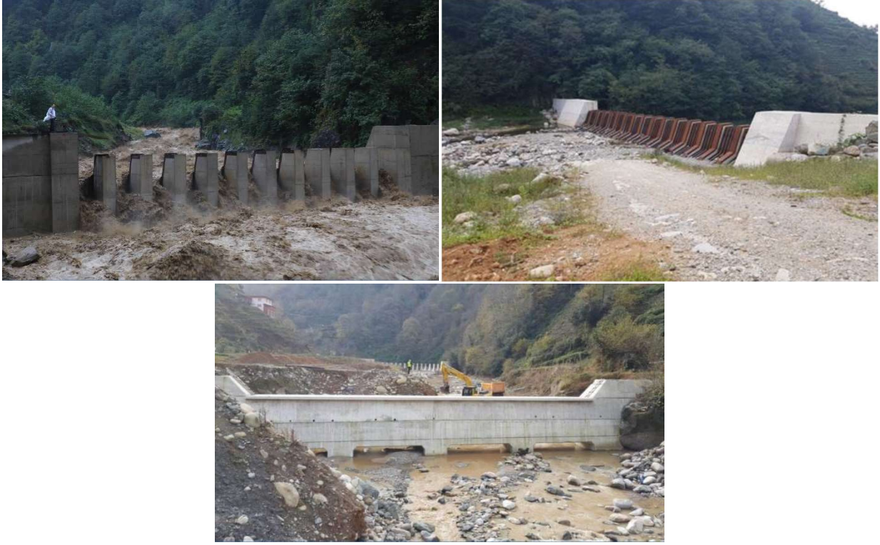
Şekil 1.14: Güneysu Deresi üzerinde yapılmış geçirgen tersip bentleri (DSİ, 2019).
