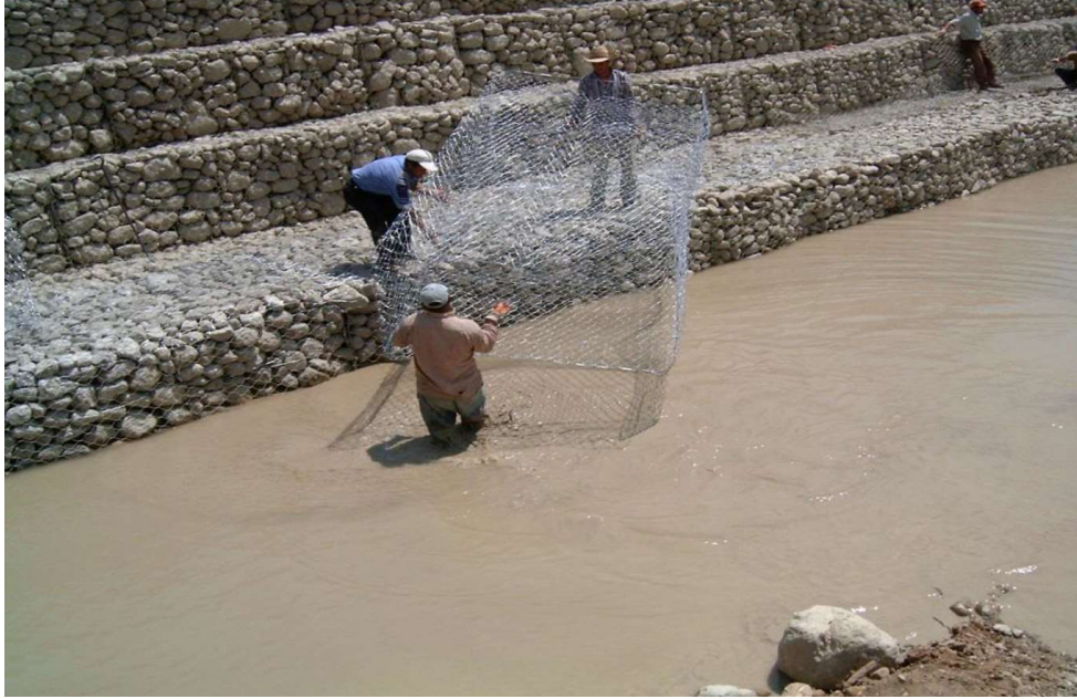
Şekil 1.12: Tel Kafes tersip bendi yapım süreci (Dinçsoy, 2008).
