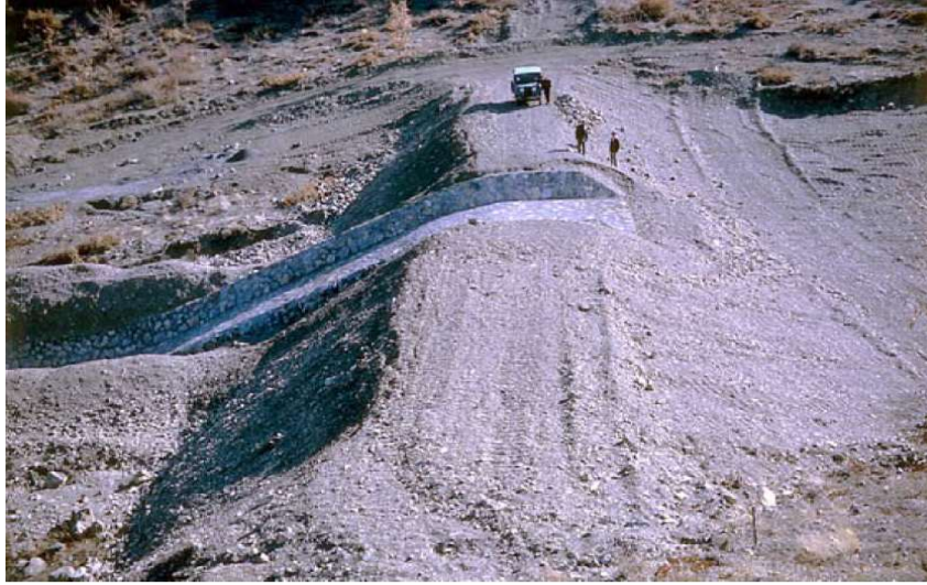
Şekil 1.10: Toprak gövdeli tersip bendi (Dinçsoy, 2008).
