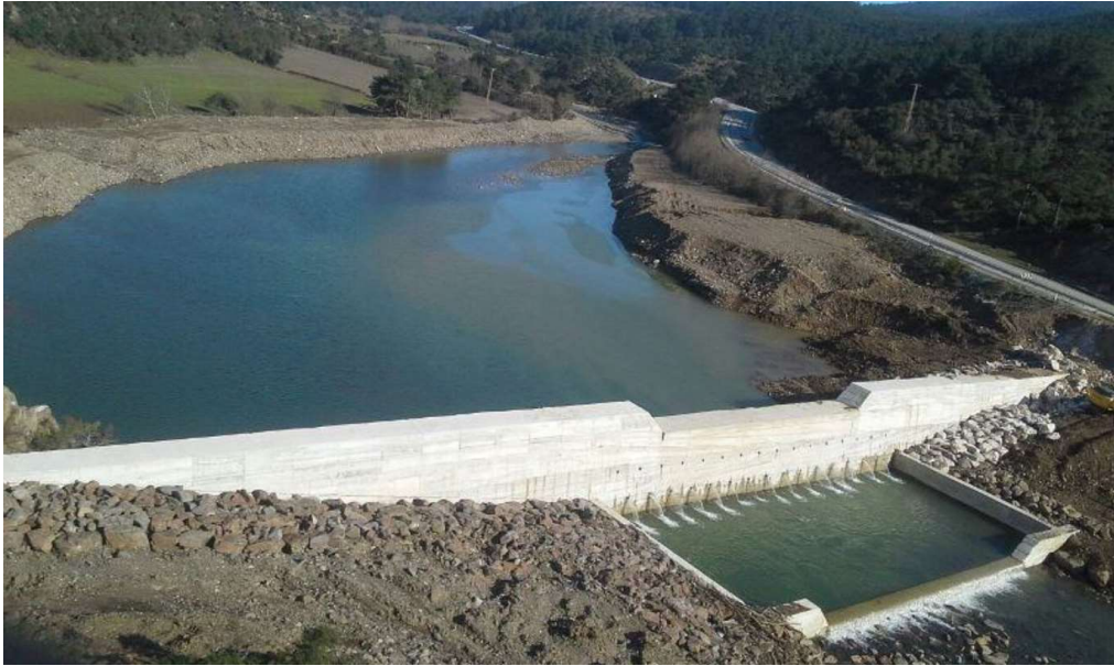
Şekil 1.9: Beton tersip bendi ve düşü havuzu (DSİ, 2019).
