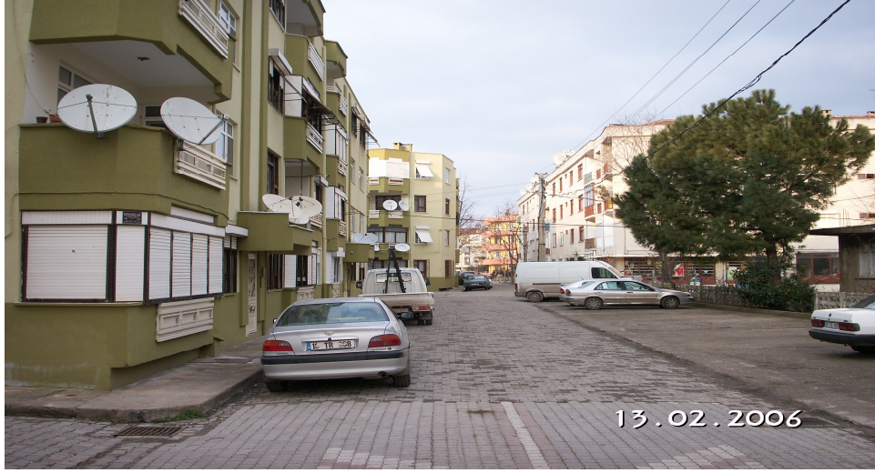
Foto 38. Kurtuluş Mahallesi'ndeki Sitelere Bir Görünüm
