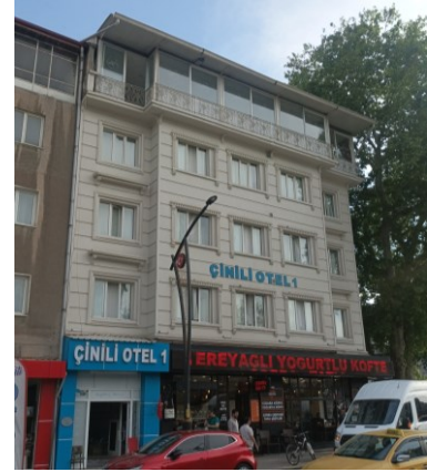
Klasik Antik Dönem taklidi otel (Korniş, pilastr görünümlü kaplama söveler)
