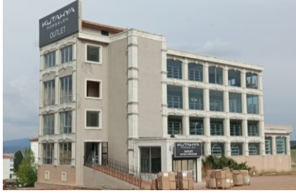
Selçuklu ve Antik Dönem taklidi ticarethane (Kilit taşlı basık kemerler, pilastr ve kat silmeleri)
