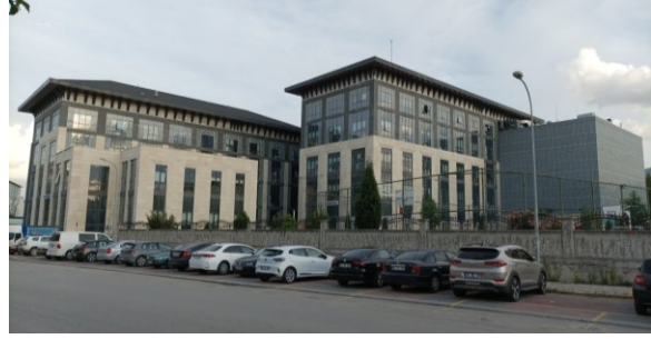
Sağ Yan ve Arka Cephe
