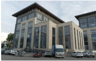
Sağ Yan Cephe
