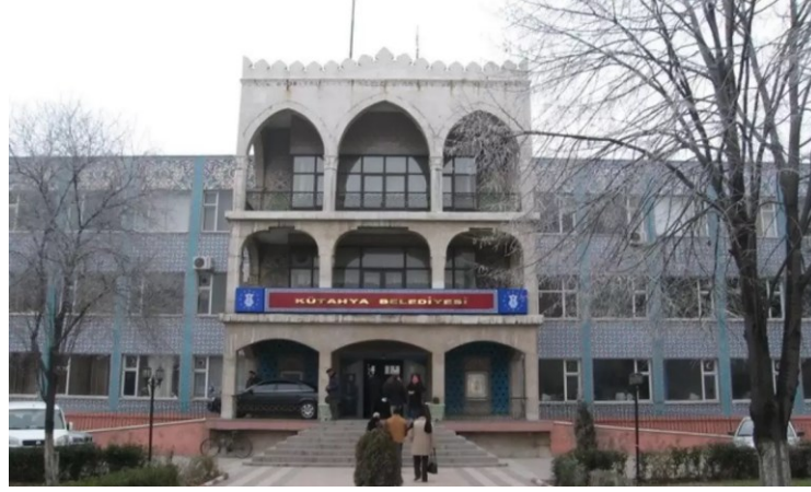
Yıkılan Eski Belediye Binası (Yapım: 1958)
